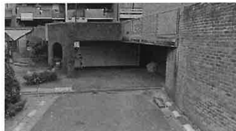
Figure 4 Entrée parking niveau 2
