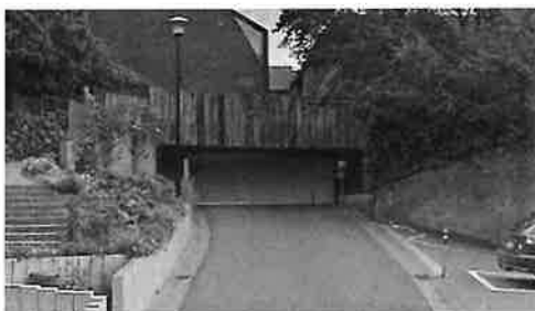
Figure 3 Entrée parking niveau 1
